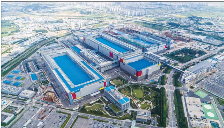
삼성전자 평택캠퍼스 전경 사진.
