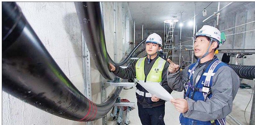
LS전선 직원이 세계 최대 송전 용량인 500kV급 HVDC 케이블이 투입되는 동해안-신가평 시공 현장을 점검하고 있다. /LS전선
