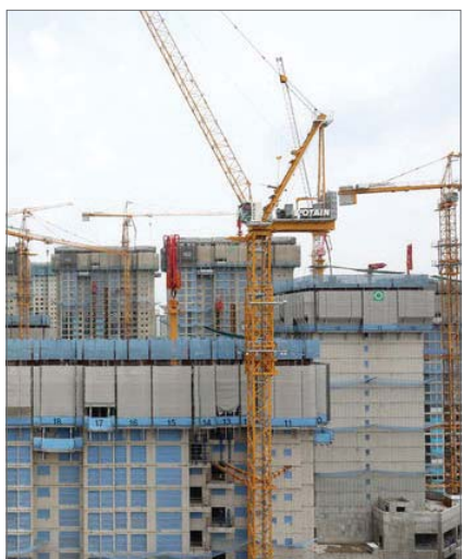
상호금융의 부실화를 예방하기 위해 대손충당금 비율이 높아진다. 서울 시내 한 아파트 공사 현장에 타워크레인이 설치돼 있다. /뉴시스
