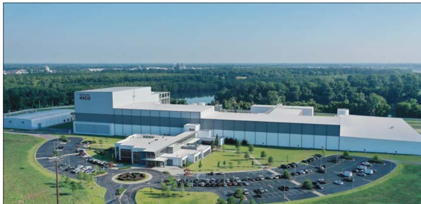
효성중공업 미국 테네시주 멤피스 초고압변압기 공장 전경.
