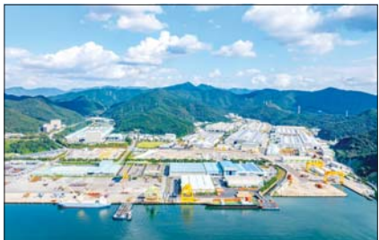
경남 창원에 위치한 두산에너지빌리티 본사 전경. /두산에너지빌리티
