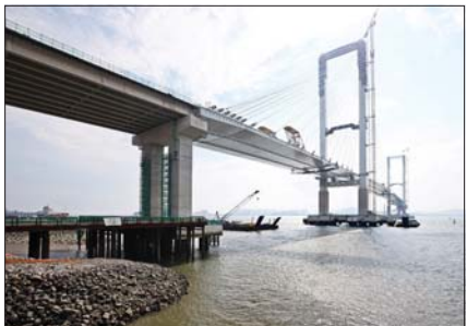
인천시 제3연륙교 건설 모습. /인천경제자유구역청
