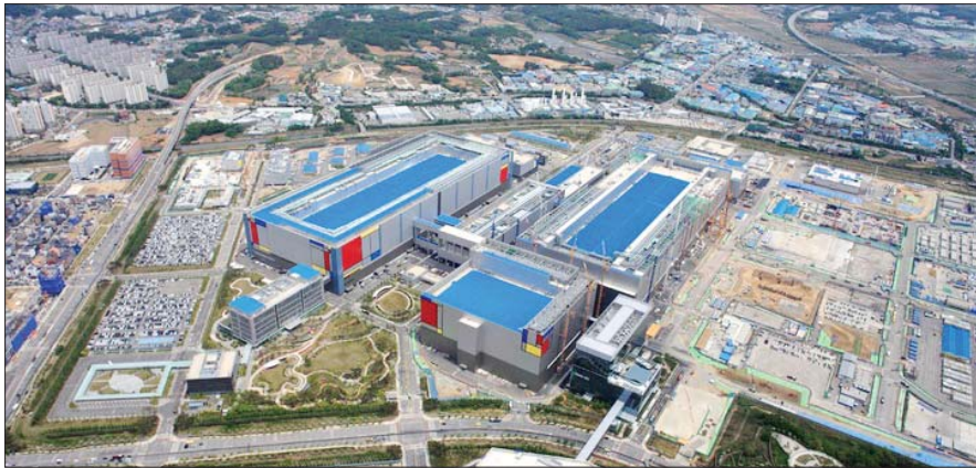
삼성전자 반도체 공장 평택캠퍼스 전경.
