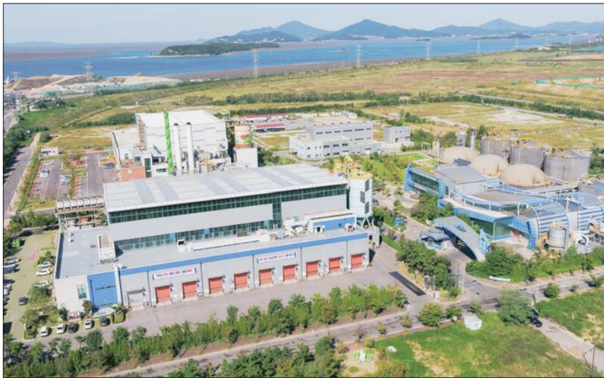
인천 서구에 조성된 자원에너지화 시설.
