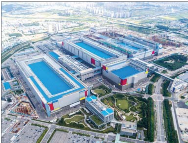
삼성전자 평택캠퍼스 전경.
