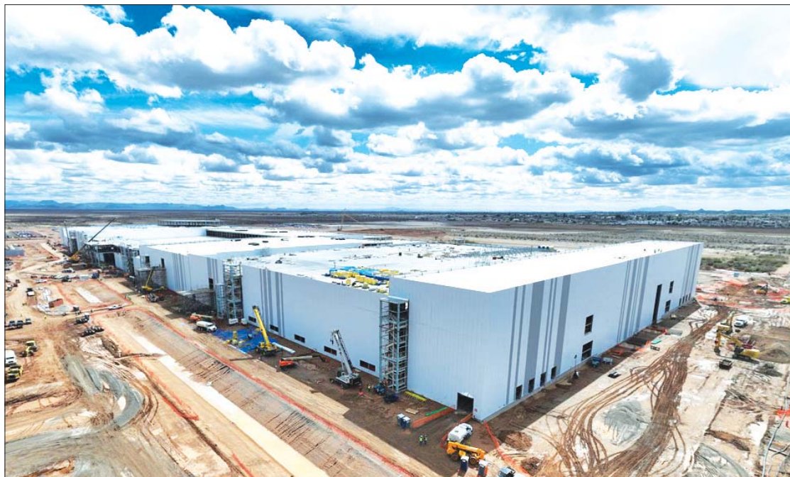
LG에너지솔루션이 건설중인 미국 애리조나 원통형 공장 전경.
