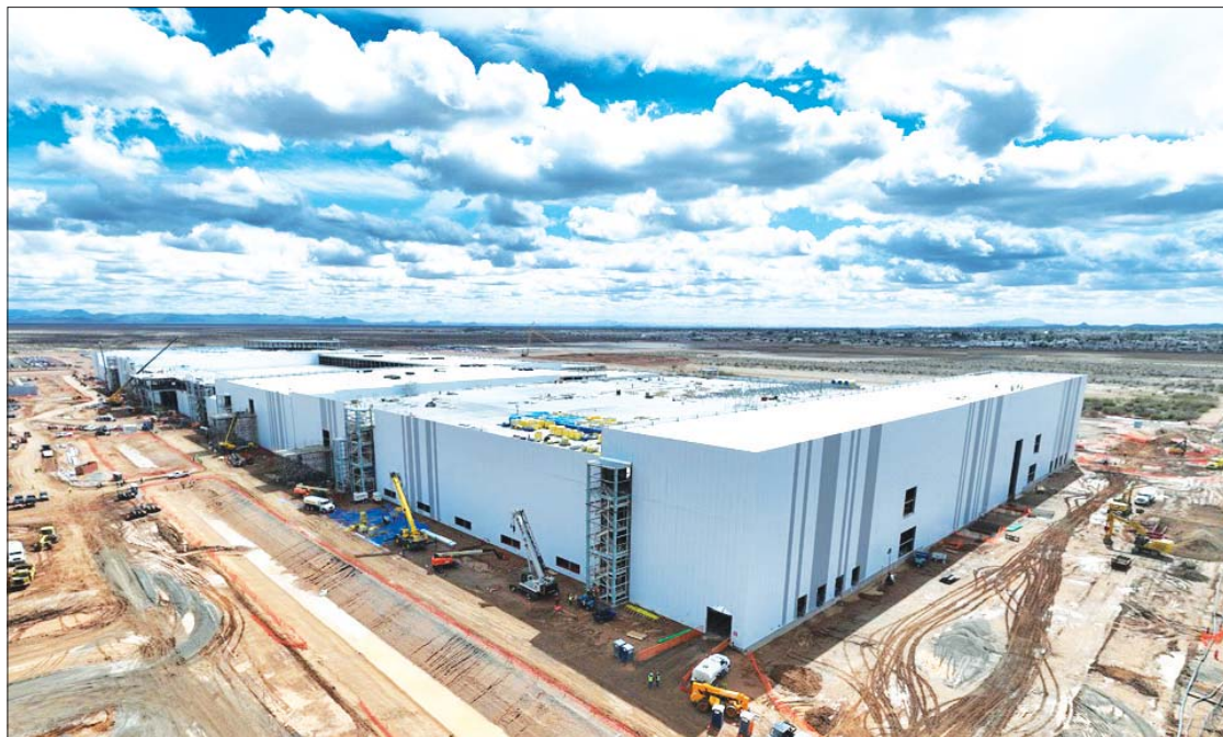
LG에너지솔루션이 건설중인 미국 애리조나 원통형 공장 전경.
