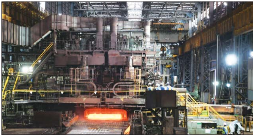
포스코 포항제철소 3후판 공장 전경.
