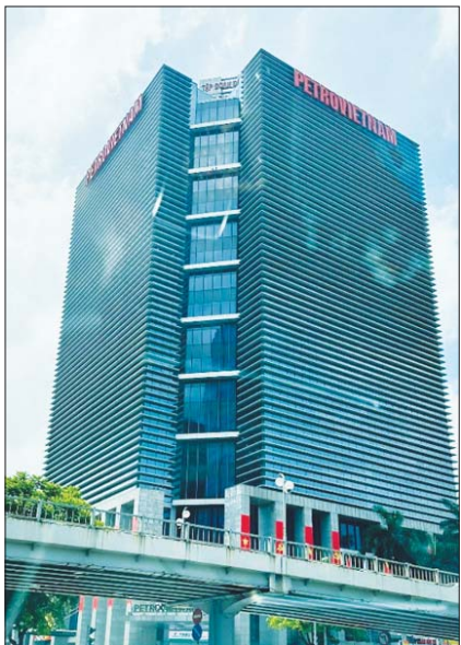
베트남 국가산업에너지공사(PVN) 본사 전경. /한전
