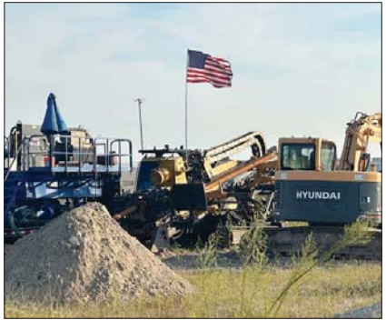
미국 조지아주 엘라벨에 위치한 현대자동차 그룹 전기차 공장 건설 현장. /뉴시스
