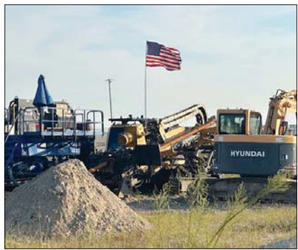
미국 조지아주 엘라벨에 위치한 현대자동차 그룹 전기차 공장 건설 현장. /뉴시스
