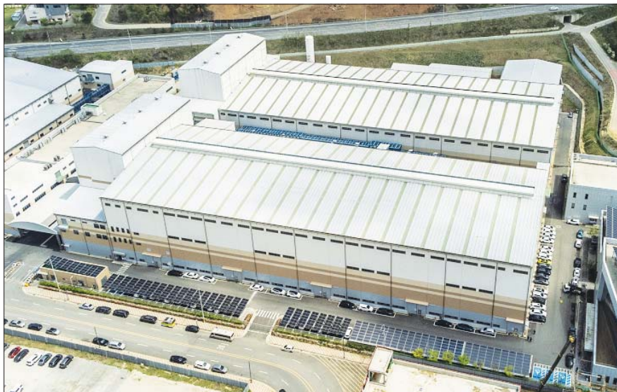
일본 배터리에 공급하는 천연흑연 음극재를 생산하는 포스코퓨처엠 세종 음극재 공장 전경. /포스코퓨처엠
