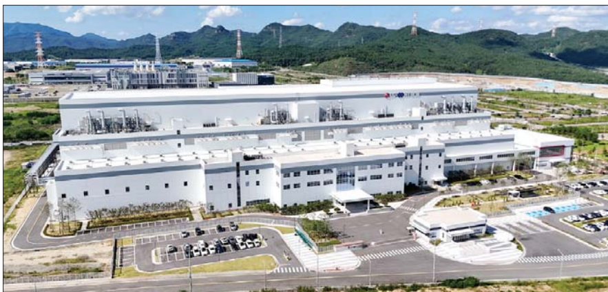
LG화학 구미 양극재 공장 LG-HY BCM 전경.
