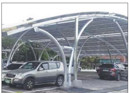
공공주차장에 캐노피형 태양광 발전설비가 설치된 모습. /뉴시스
