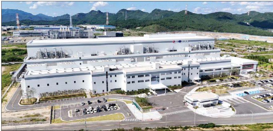
LG화학 구미 양극재 공장 LG-HY BCM 전경.
