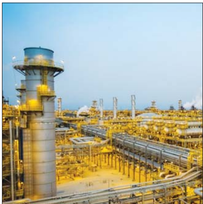
사우디아라비아 파드힐리 프로젝트 전경. /포스코
