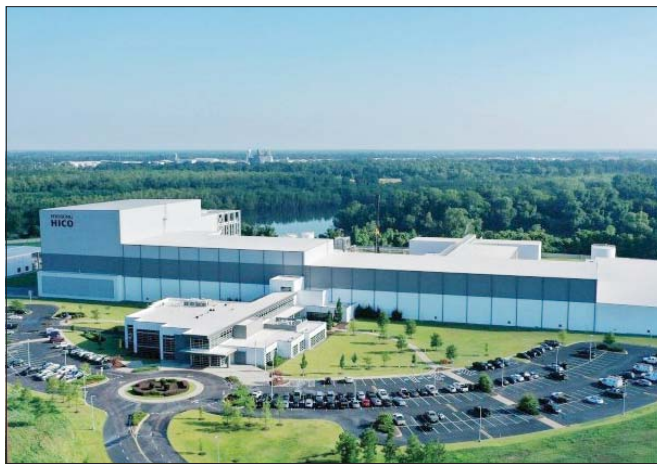
/HD현대 효성중공업 미국 테네시 멤피스 초고압변압기 공장 전경.
