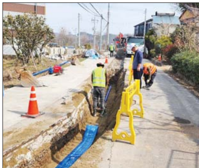
진주시, 지방상수도 현대화사업 공사현장
