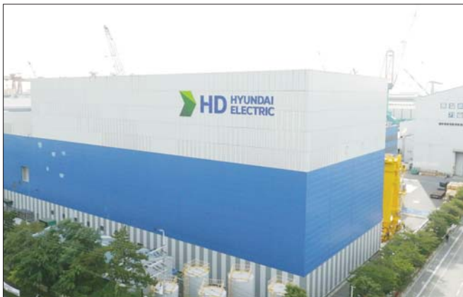
HD현대일렉트릭 변압기 스마트 공장 외경
