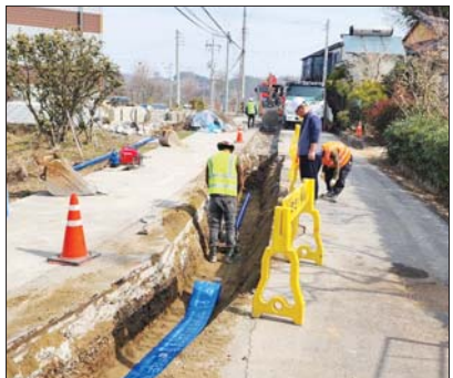
진주시, 지방상수도 현대화사업 공사현장
