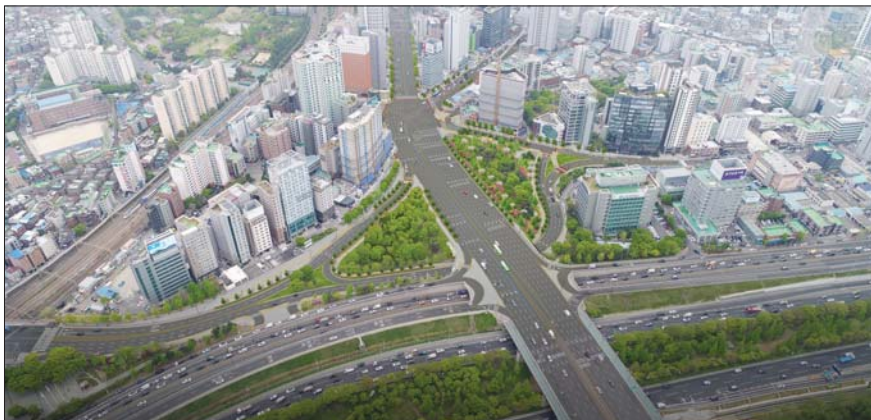
공사 후 영등포 로터리 조감도.
