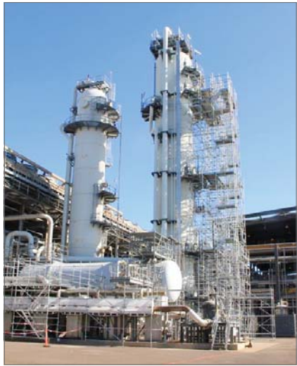
호주 에너지 기업 산토스가 운영하는 다윈 LNG 터미널 내 이산화탄소 분리 공정을 위한 탄소 포집 설비가 설치되어 있다. 사진은 흡수탑 모습. /SK E&S
