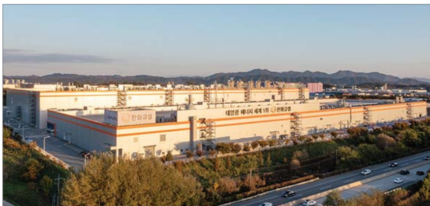
한화큐셀 진천공장 전경
