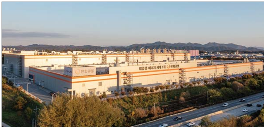
한화큐셀 진천공장 전경
