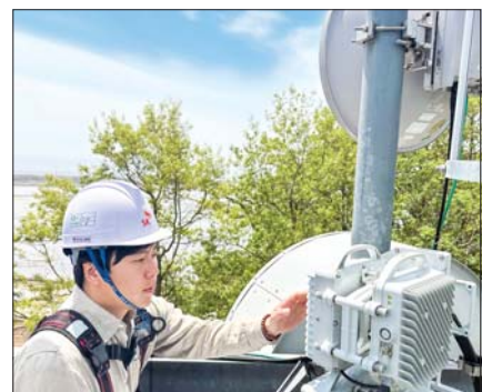
SKT 직원들이 도서 지역에 설치된 5G 마이크로웨이브 통신 장비를 점검하는 모습. /SKT
