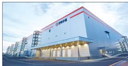
한화큐셀 진천공장 전경.
