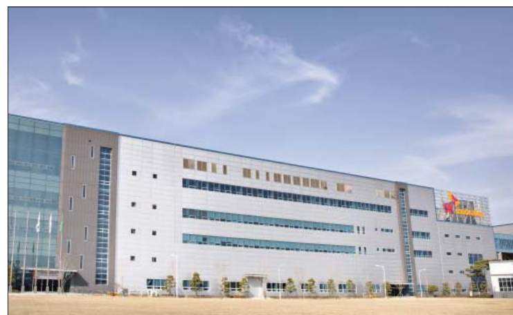
/LG에너지솔루션 SK온 서산 배터리 공장
