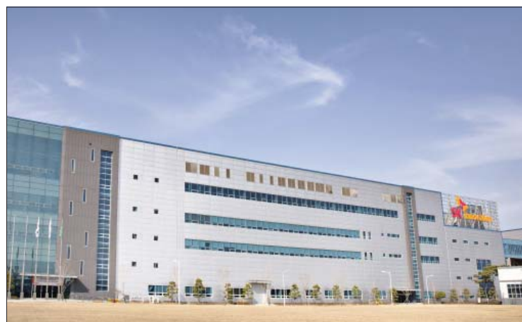
/LG에너지솔루션 SK온 서산 배터리 공장
