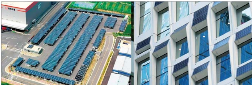
한화큐셀 진천공장 주차장(왼쪽)과 서울 장교동 한화빌딩에 설치된 대표적 분산에너지 자원인 태양광 발전소
